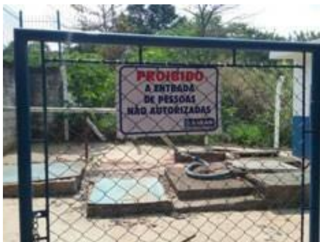
Foto 59: Portão de acesso à elevatória
