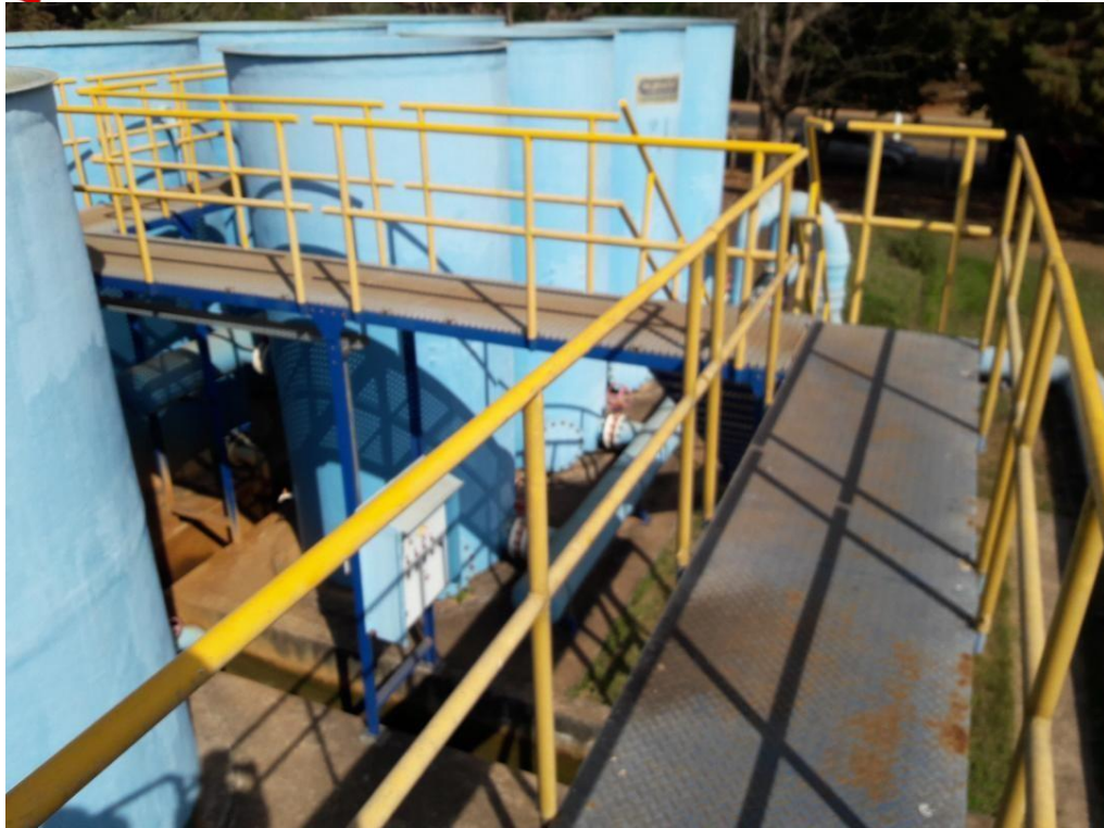
Foto 17: Parte ampliada da ETA III.
