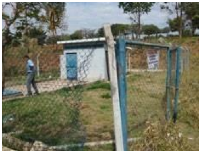
Foto 62: Detalhe da abertura na cerca
