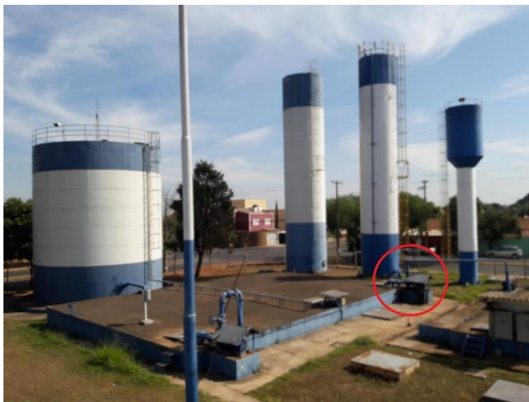
Foto 41: Conjunto Moto bomba - Sistema da ETA III – Elevatória 1.
