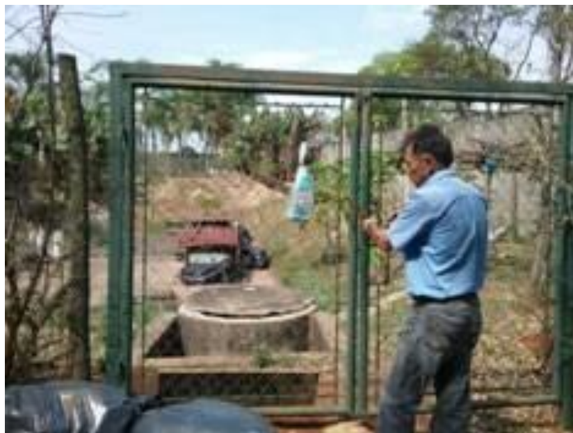
Foto 81: Portão de acesso à elevatória
