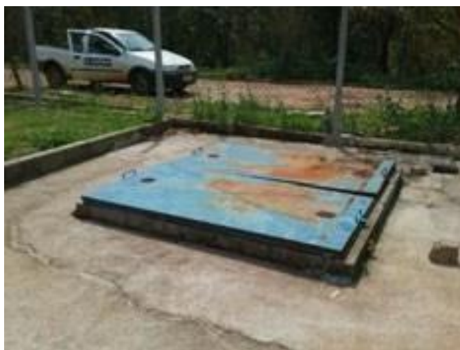
Foto 64: Poço de sucção de esgoto
