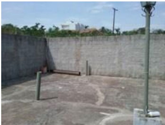
Foto 80: Respirios do poço pulmão
