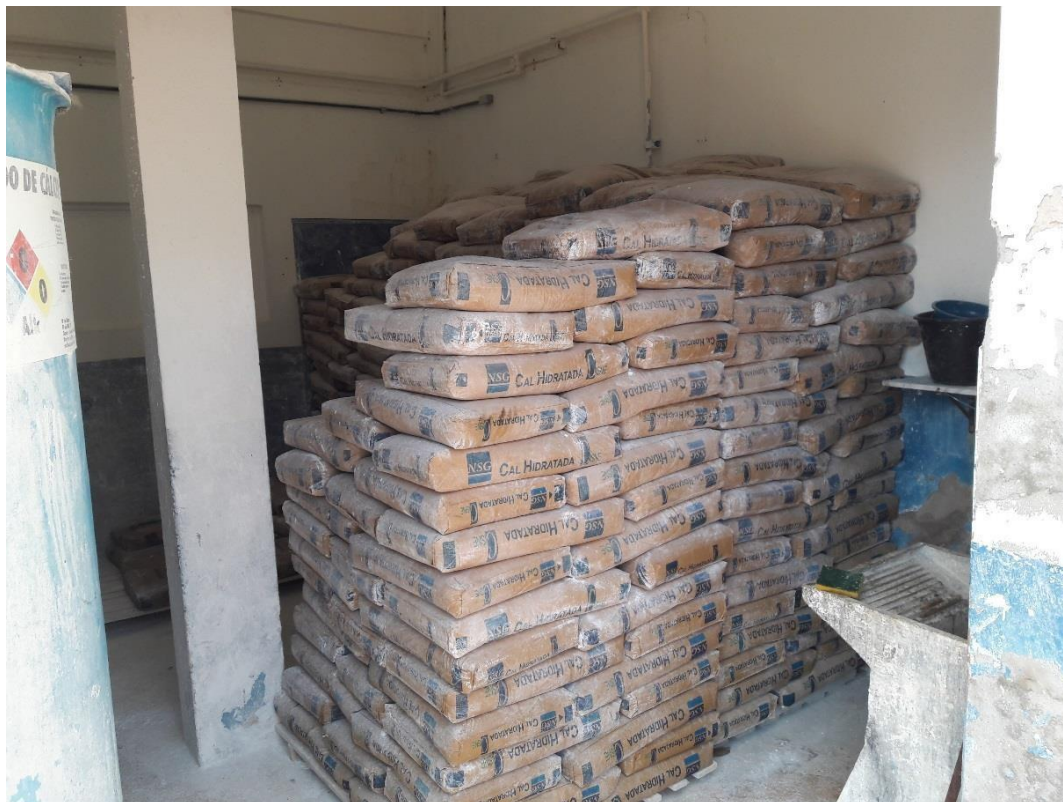
Foto 6: Armazenamento de Produtos Químicos
