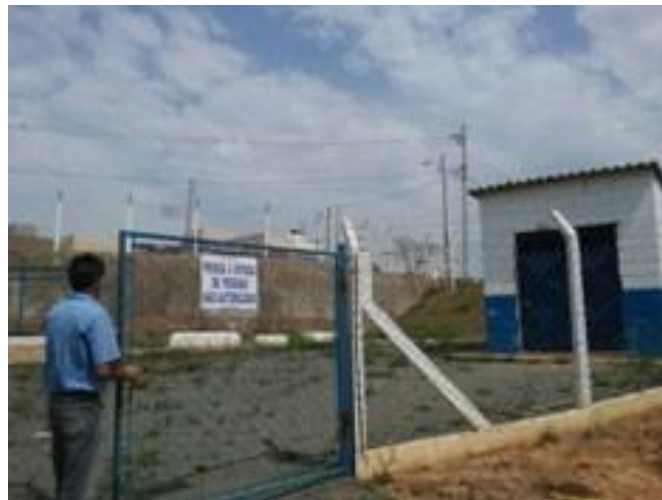
Foto 71: Aspecto externo da elevatória
