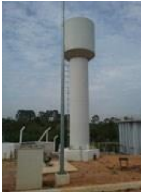
Foto 44: Reservatório de uso interno
