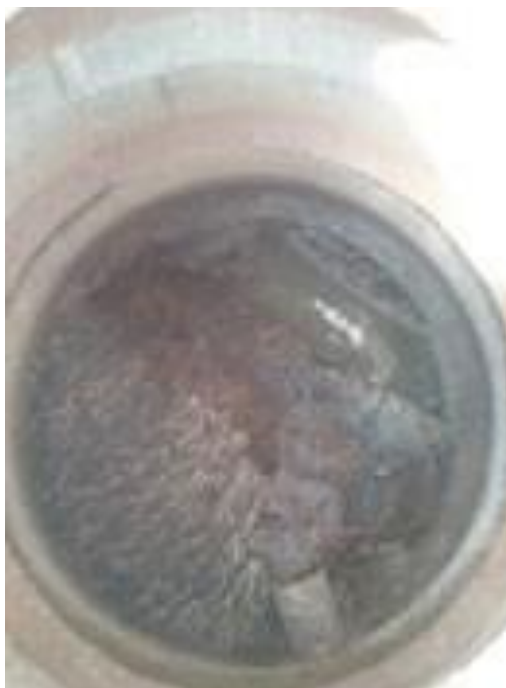
Foto 68: Entrada de esgoto
