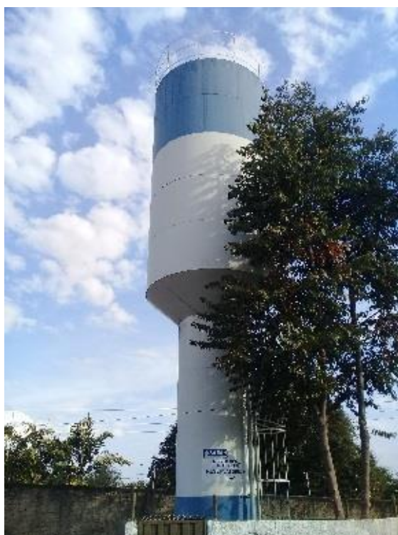
Foto 29: Reservatório Residencial do Bosque
