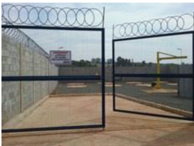
Foto 65: Portão de acesso à elevatória
