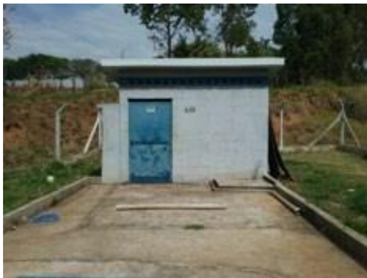
Foto 63: Aspecto externo da elevatória
