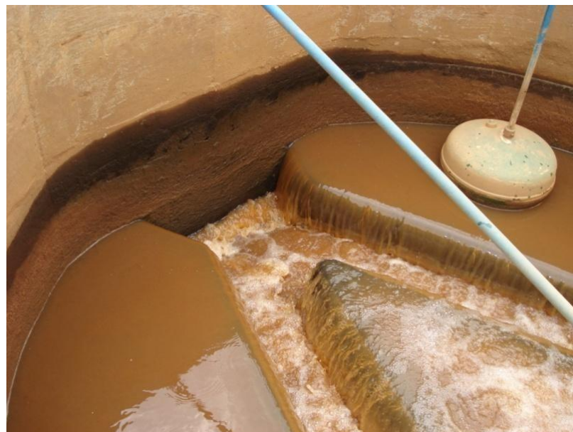
Foto 10: Retrolavagem do Filtro.
