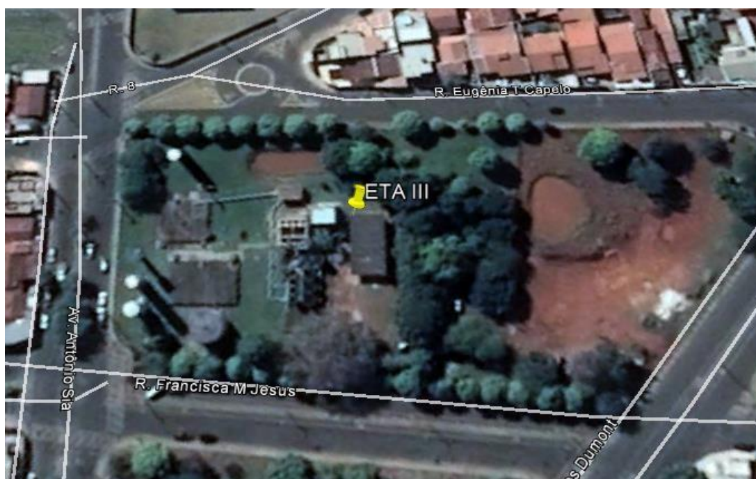
Figura 11: Localização da ETA III.
