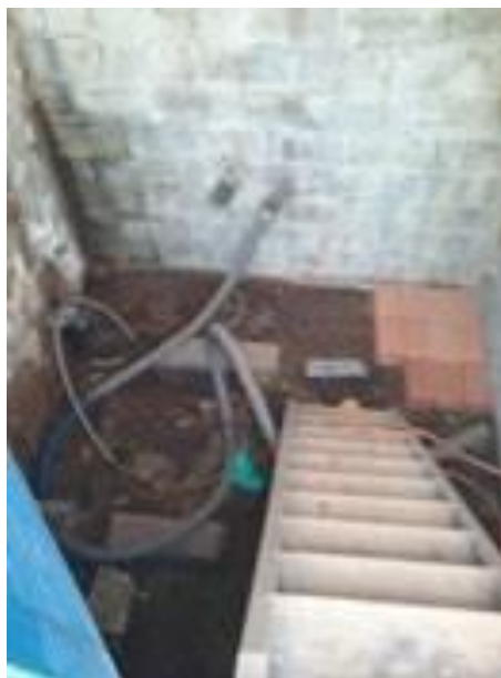
Foto 60: Casa de bombas desativada
