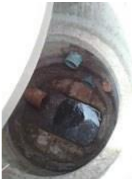
Foto 76: Poço de entrada do esgoto
