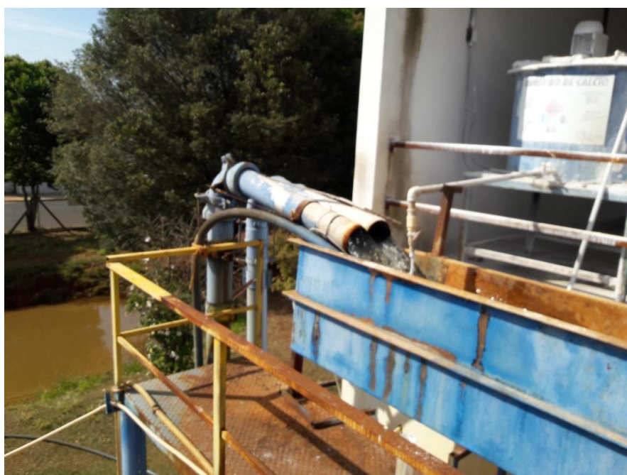
Foto 12: Chegada de água bruta na ETA.
